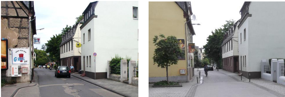
Abbildung 18: Beispiel Umgestaltung Engstelle, vorher (links) und nachher (rechts)
