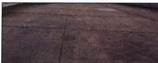
Abb. 4: Mit Betonplatten versiegelte Fläche innerhalb des Plangebiets
