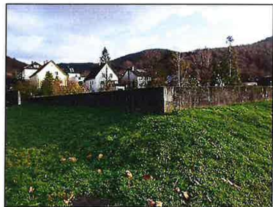
Abb. 5: Einfriedung des Plangebiets im Nordwesten
