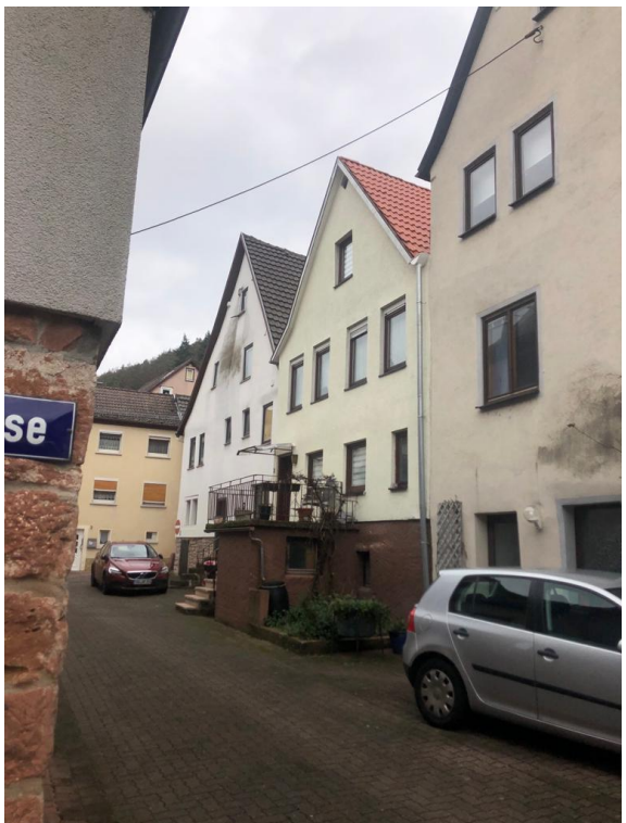
Gebäude nach Anstrich im Farbton S0505-Y10R und neuer Eindeckung mit Dachsteinen Harzer Pfanne 10 Star matt, klassisch rot
